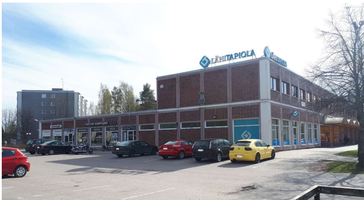
Keskuskatu 4 pohjoisesta päin kuvattuna toukokuussa 2018
